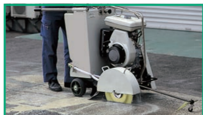
二次製品・道路・ 铸铁管の切断
